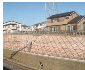
大雨対策 （法面補強工事）
