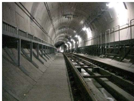
照明LED化（トンネル内）
