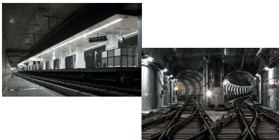
工事完了後の調布駅
