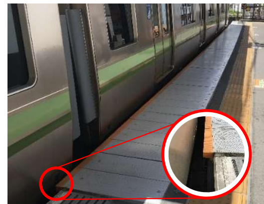
転落防止ゴムの設置 （隙間対策）
