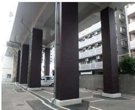
高架橋耐震補強
