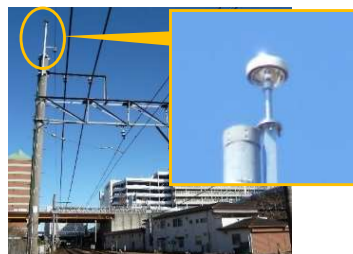
雷害対策（避雷針の設置）
