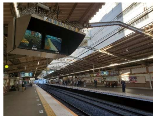
リアルタイム伝送機能付き ホーム上カメラの設置 (2022年度 21/69駅 完了)
