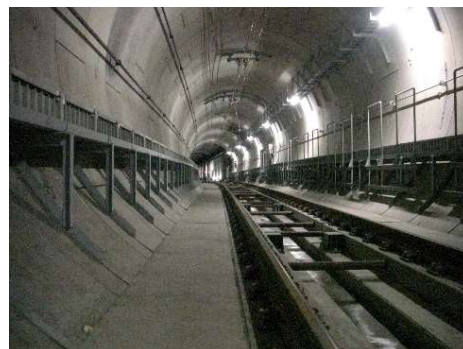
照明LED化（トンネル内）
