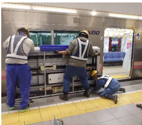
ホームドアの整備（左：施工中 右：施工後）
