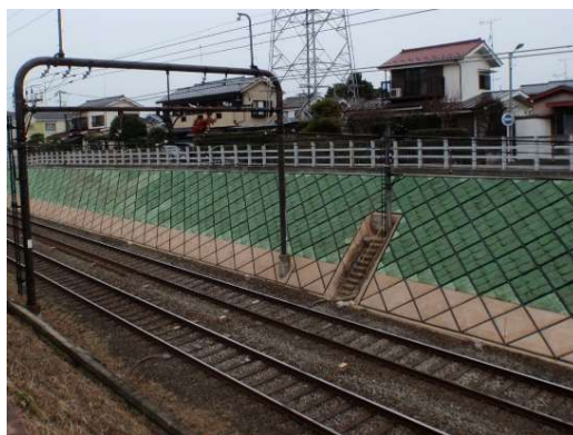
法面補強工事
