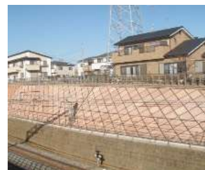
大雨対策 （法面補強工事）
