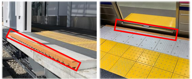
《転落防止ゴム設置の様子》
