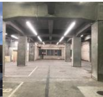
▲東京 PJ 改修前内観
