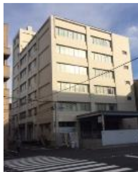
▲東京 PJ 改修前外観
