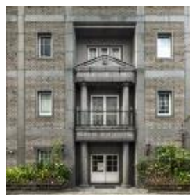
▲広島 PJ 改修前外観
