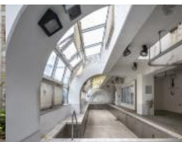
▲広島 PJ 改修前内観
