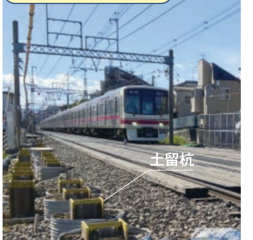
土留杭設置完了状況
