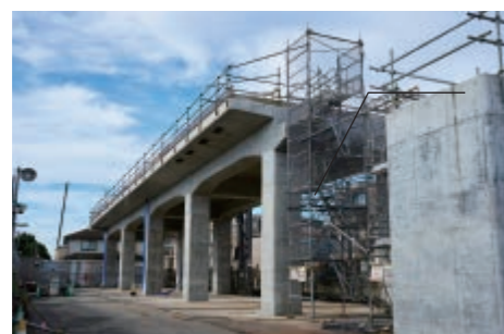
高架橋構築状況(代田橋7号踏切西側)
