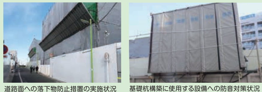
道路面への落下物防止措置の実施状況 基礎杭構築に使用する設備への防音対策状況
