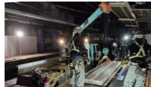
ホーム仮設化施工状況
