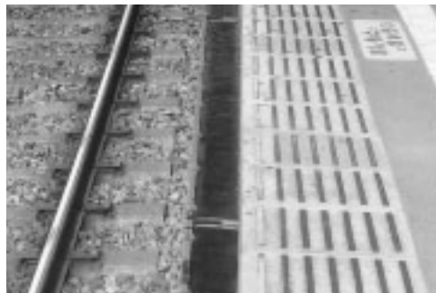
転落検知装置
