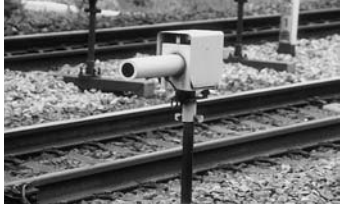
踏切障害物検知装置
