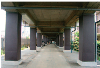
鋼板巻きによる高架橋柱耐震補強
