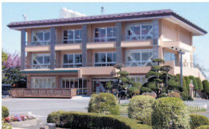
施工例:明星大学12号館(学友会館)改修工事(京王建設)
