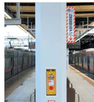
列車非常停止ボタン
