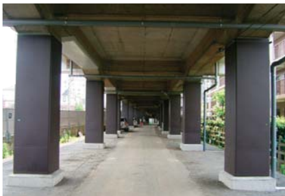
鋼板巻きによる高架橋柱耐震補強
