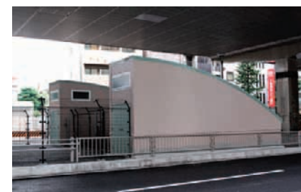
幡ヶ谷駅に新設した避難通路(上)と地上出口(下)
