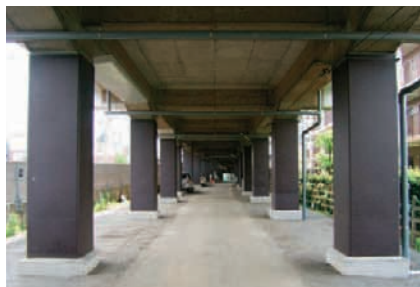
鋼板巻きによる高架橋柱耐震補強
