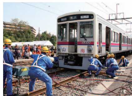
事故復旧訓練
