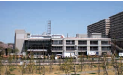
立川市庁舎の管理業務を受注（京王設備サービス）
