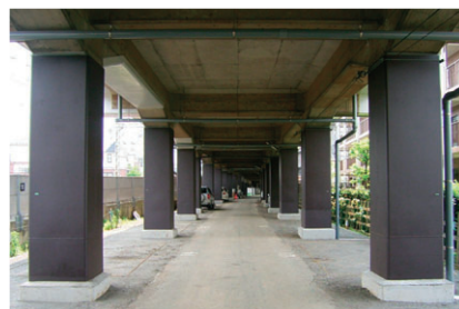
鋼板巻きによる高架橋柱耐震補強
