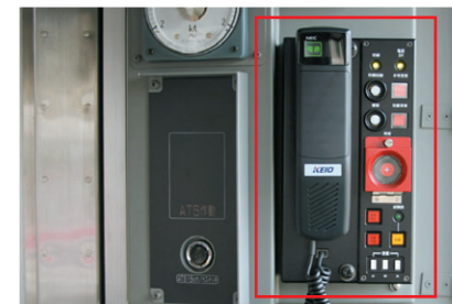
防護無線装置
