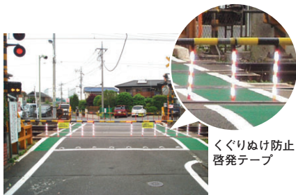
踏切歩道部のカラー舗装化
