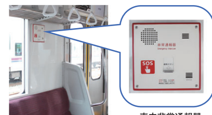
車内非常通報器
