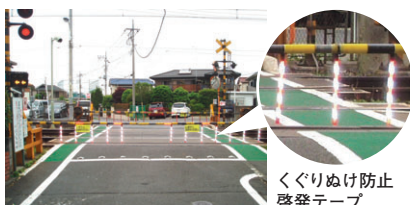
踏切歩道部のカラー舗装化
