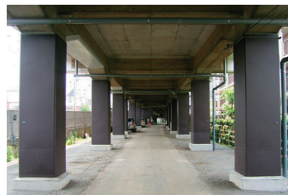
鋼板巻きによる高架橋柱耐震補強
