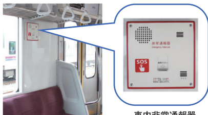
車内非常通報器
