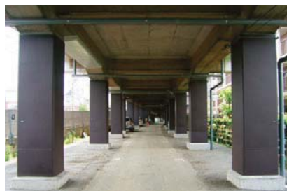
鋼板巻きによる高架橋柱耐震補強
