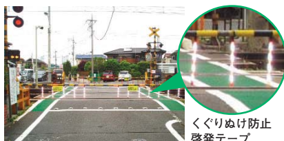
踏切歩道部のカラー舗装化
