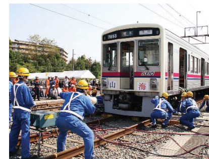
事故復旧訓練
