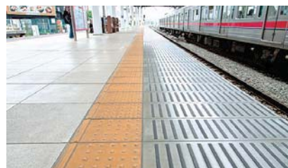
内方線付き点状ブロック
