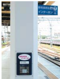
駅係員呼出 インターホン
