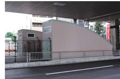
幡ヶ谷駅の避難通路(上)と地上出口(下)
