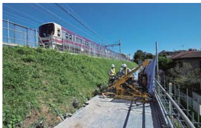
盛土区間の耐震補強
