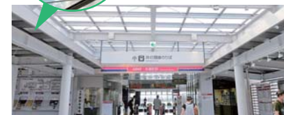
透過式の太陽光パネル
