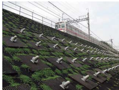
盛土区間の耐震補強
