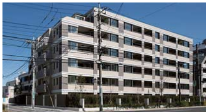
施工した三菱地所レジデンスの分譲マンション
