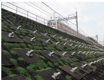
盛土区間の耐震補強
