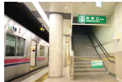
幡ヶ谷駅の避難通路
