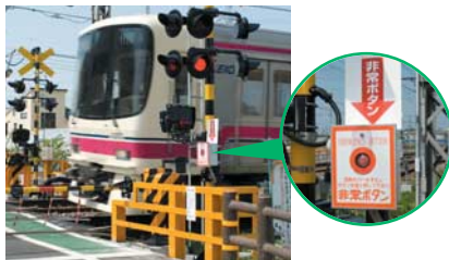
踏切支障報知装置(非常ボタン)
