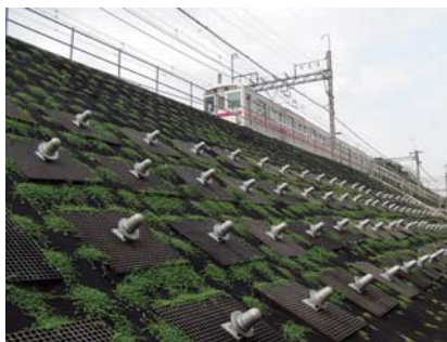
盛土区間の耐震補強
