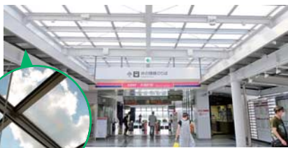
透過式の太陽光パネル
