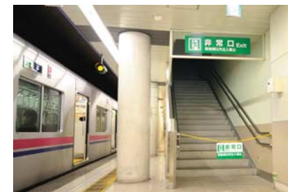
幡ヶ谷駅の避難通路
