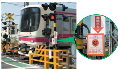
踏切支障報知装置(非常ボタン)
