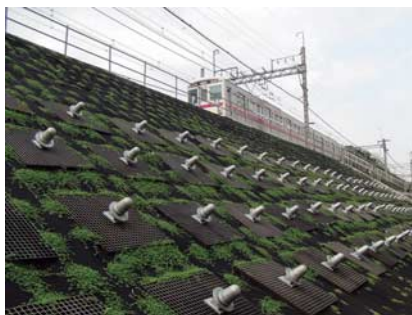
盛土区間の耐震補強
