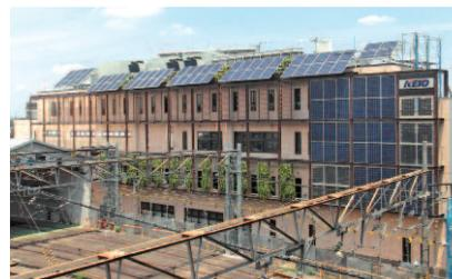
2013(平25)年に、高幡不動駅の敷地内に、太陽光発電システムなど13種類の環境に配慮した設備を組み合わせ活用した、鉄道現業の事務所(高幡不動乗務区・施設管理所)を開設しました。従来の施設と比べて、約30%の省電力と節水を実現しています。
