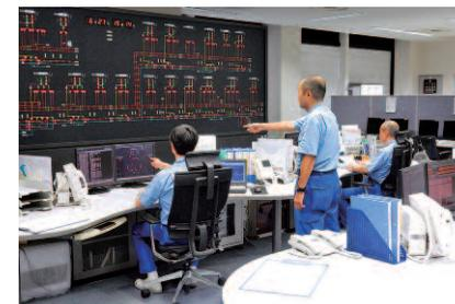
列車運転用電力と駅設備や信号保安設備などに用いる付帯用電力を供給する、20カ所の変電所の運転状況や送電状況を、集中監視制御システムにより24時間体制で監視しています。
