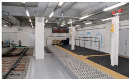
実際のホームを再現し、列車非常停止ボタンや転落検知装置などの機器を設置しています。これらの機器を実際に動作させて、異常時における迅速かつ的確な対応ができるよう訓練を行っています。
