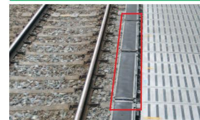
曲線ホームなど、車両とホームとの隙間が広く空いてしまう箇所がある14駅に設置しています。お客様がホームから転落された場合、この装置が転落を検知し、列車の乗務員や駅係員に知らせるとともに、付近の列車を自動的に停止させます。
