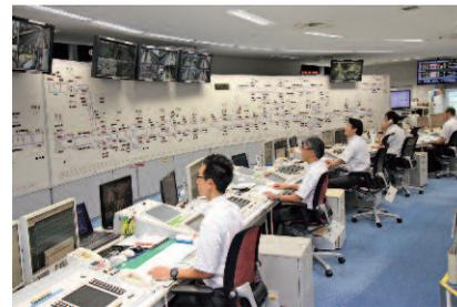
列車の運行を円滑に行うため、TTC(列車運行管理システム)により、列車の進路設定、出発指示合図などを自動制御しています。事故発生時などには、列車の位置や遅れなどを総合的に判断し、運行ダイヤの整理・復旧を図るとともに、駅の「お客さま案内ディスプレイ」や「車内案内表示器」などを通じて運輸指令所から一括してお客様に最新情報をご案内しています。
