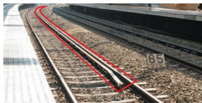
国からの通達では、半径200m以下の曲線に脱線防止ガードを設置することが定められていますが、当社では従来からその基準を上回る半径300m以下の曲線に設置しています。また、ポイント(分岐器)や踏切道にも順次設置しています。
