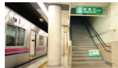
幡ヶ谷駅の避難通路
