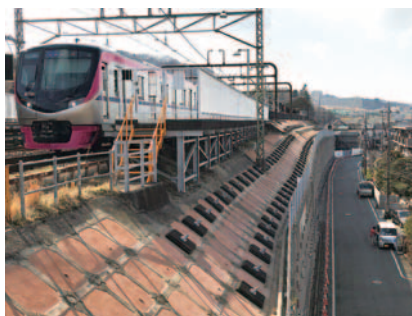
盛土区間の耐震補強
