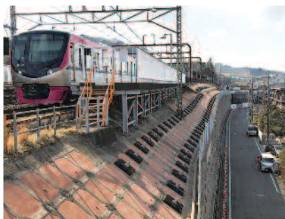
盛土区間の耐震補強
