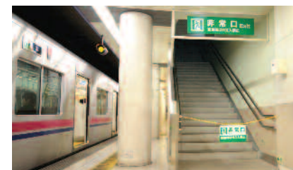
幡ヶ谷駅の避難通路
