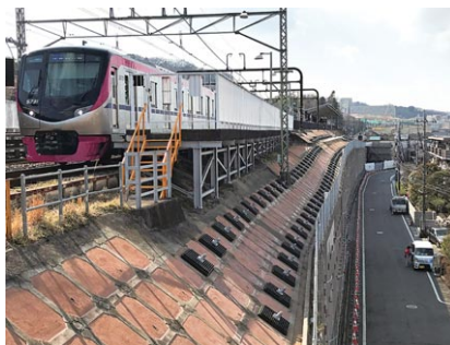
盛土区間の耐震補強
