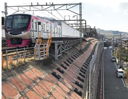
盛土区間の耐震補強
