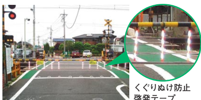
踏切歩道部のカラー舗装化
