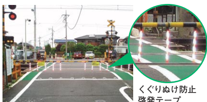
踏切歩道部のカラー舗装化
