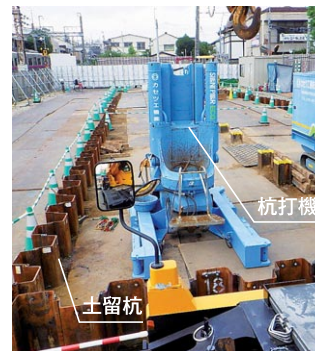
明大前駅付近(第2工区)
