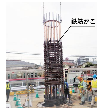
明大前駅付近(第2工区)
