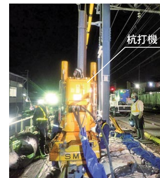
千歳烏山駅～仙川駅間(第8工区)
