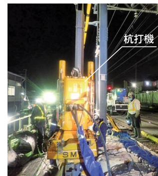
千歳烏山駅～仙川駅間(第8工区)
