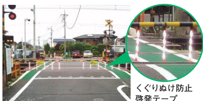
踏切歩道部のカラー舗装化
