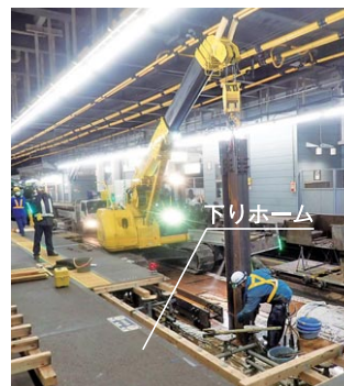
芦花公園駅付近(第6工区)
