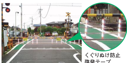
踏切歩道部のカラー舗装化
