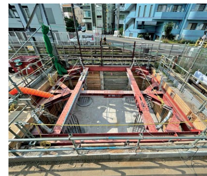
明大前駅付近(第2工区)
