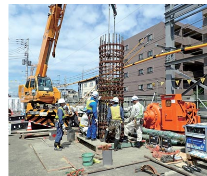
千歳烏山駅～仙川駅間(第8工区)
