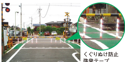
踏切歩道部のカラー舗装化
