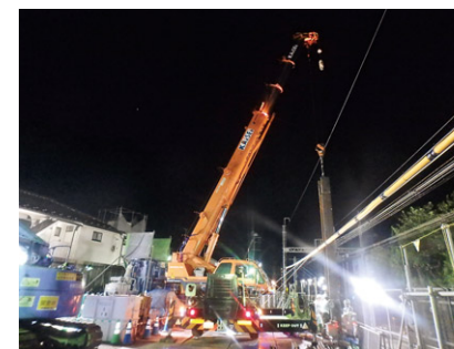
千歳烏山駅～仙川駅間(第8工区)
