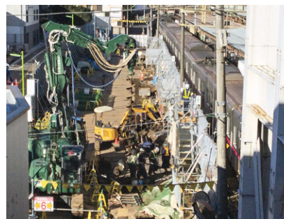
桜上水駅付近(第4工区)
