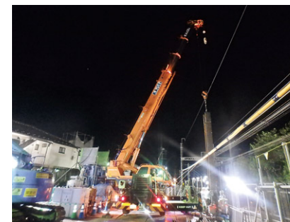
千歳烏山駅～仙川駅間(第8工区)
