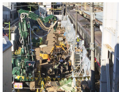
桜上水駅付近 (第4工区)
