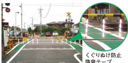
踏切歩道部のカラー舗装化
