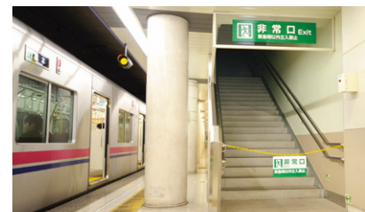
幡ヶ谷駅の避難通路
