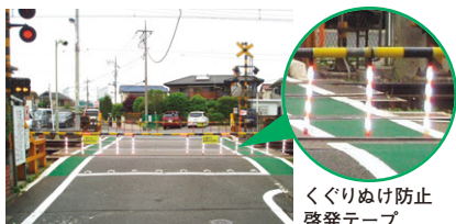
踏切歩道部のカラー舗装化
