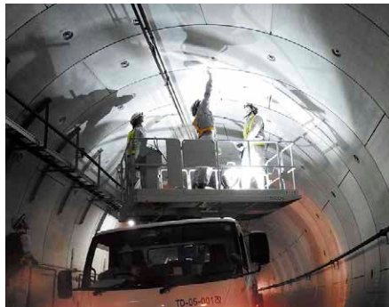
トンネル天井部の点検
