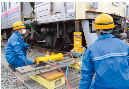
脱線車両の復旧
