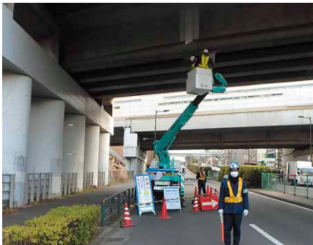
高架橋の点検
