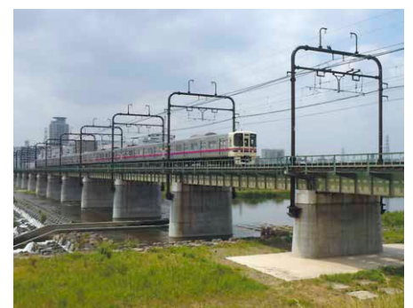
多摩川橋梁耐震補強
