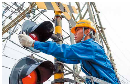
踏切保安設備の点検
