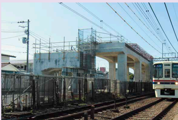
高架橋構築箇所(明大前駅付近)
