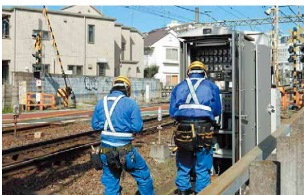
踏切保安設備の点検
