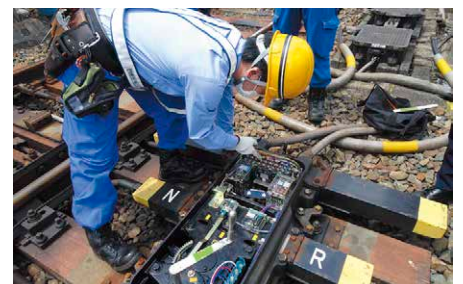
転てつ器の点検
