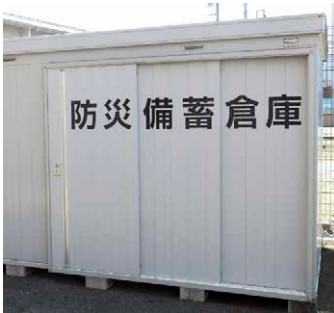
各拠点に設置の防災備蓄倉庫
