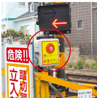
踏切支障報知装置 (非常ボタン)
