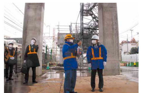
連立工事現場の視察
