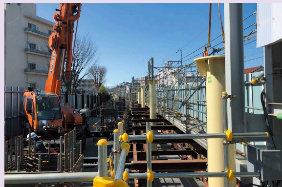
駅部高架橋構築箇所(芦花公園駅付近)
