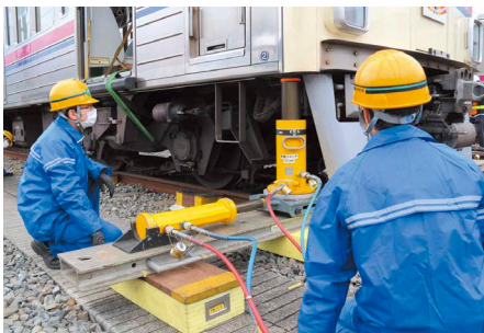
脱線車両の復旧
