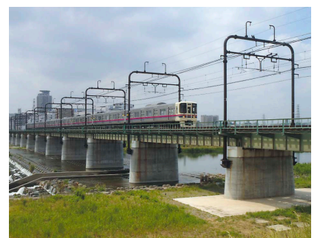
多摩川橋梁耐震補強
