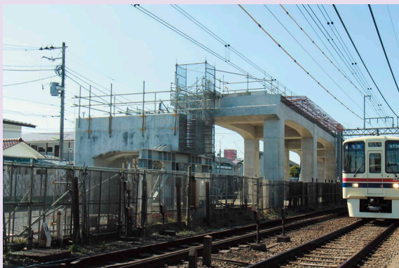
高架橋構築箇所(明大前駅付近)
