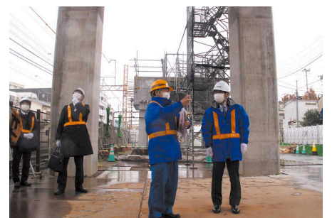
連立工事現場の視察
