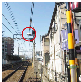
三次元レーザーダ式障害物検知装置
