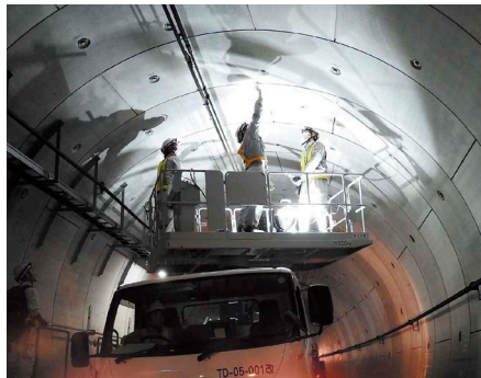
トンネル天井部の点検
