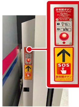
ホームドア非常開ボタン
