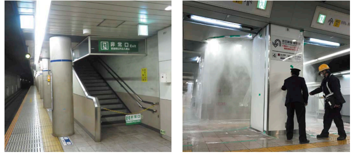
幡ヶ谷駅の非常口階段
