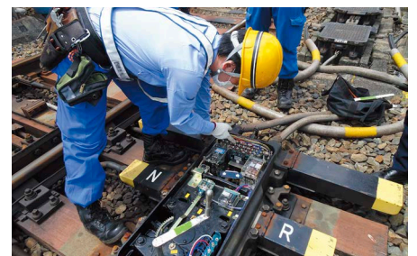
転てつ器の点検
