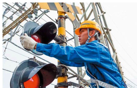
踏切保安設備の点検
