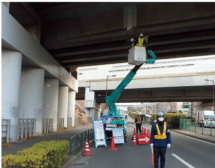
高架橋の点検
