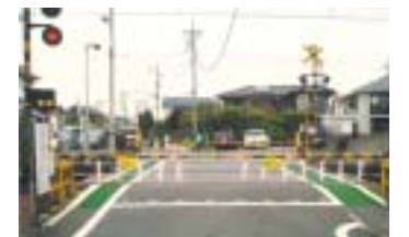
歩道部分のカラー舗装化
