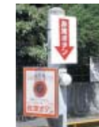
踏切支障報知装置
