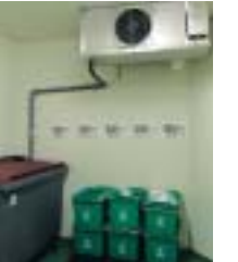
京王聖蹟桜ヶ丘ショッピングセンターのテナント別・生ゴミ保管所
