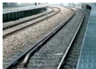
脱線防止のガードレール
