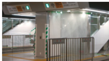
水の幕で防火区画を形成するウォータースクリーン（新宿駅）
