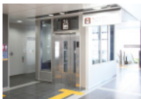
エレベーター
