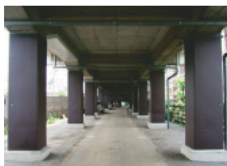
鋼板巻きによる高架橋柱耐震補強
