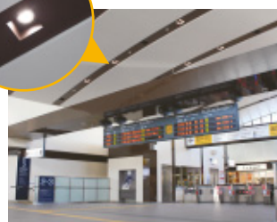
駅構内のLED照明
