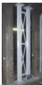
鋼柱増設によるずい道耐震補強
