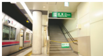
新たに設置した避難通路（幡ヶ谷駅）
