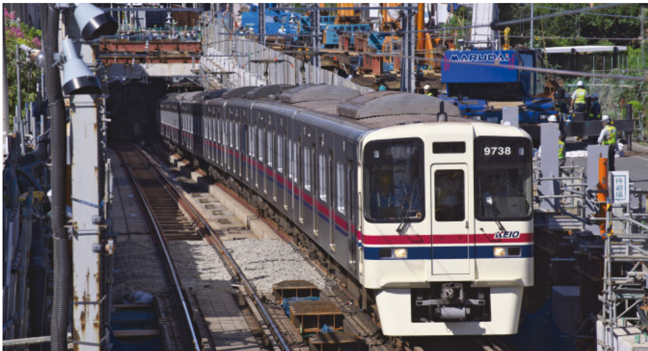
京王線と道路が立体交差する国領駅付近
