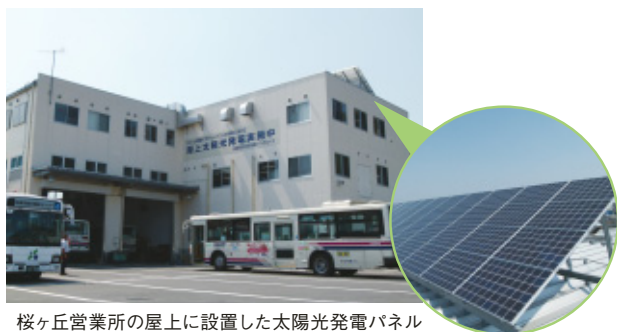
桜ヶ丘営業所の屋上に設置した太陽光発電パネル
