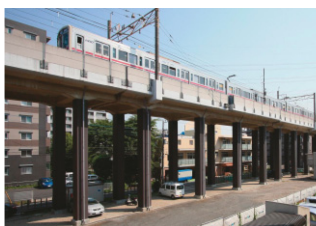
銅板巻きによる高架橋柱耐震補強
