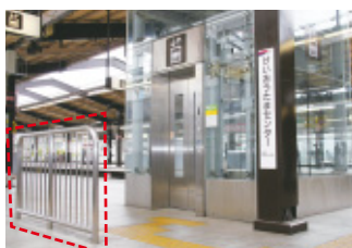
エレベーター出入口の転落防止柵
