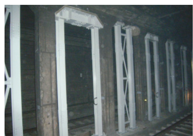
鋼柱増設によるずい道耐震補強
