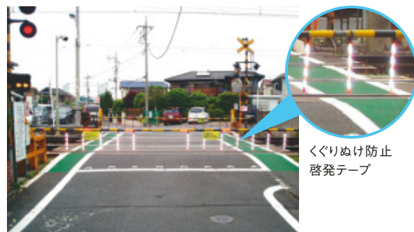
踏切歩道部のカラー舗装化
