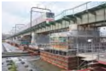
耐震補強工事を進めている京王線多摩川橋梁
