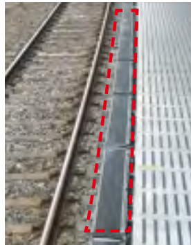
転落検知装置(マットスイッチ)
