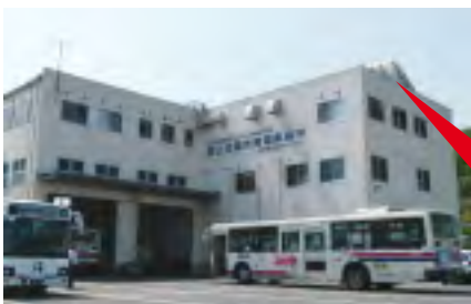
京王電鉄バス桜ヶ丘営業所屋上の太陽光発電パネル
