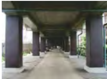
鋼板巻きによる高架橋柱耐震補強
