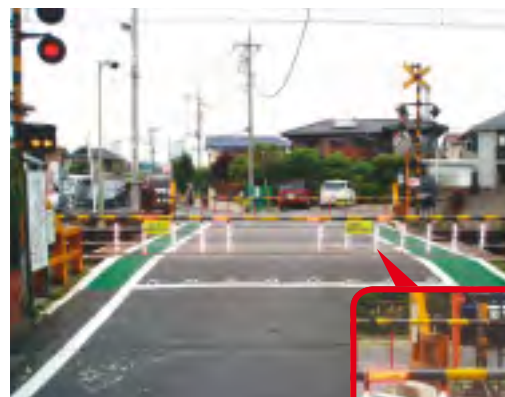
踏切歩道部のカラー舗装化
