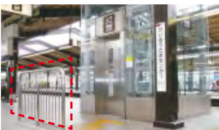
エレベーター出入口の転落防止柵
