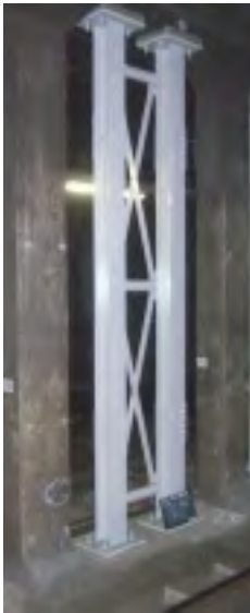
鋼柱増設によるずい道耐震補強
