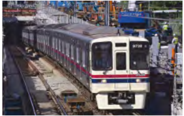
京王線と道路が立体交差する国領駅付近
