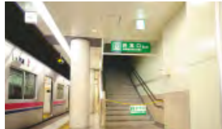
新たに設置した避難通路(幡ヶ谷駅)
