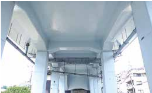
剥離対策を施した高架橋
