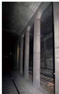
(補強前) 新宿ずい道中柱耐震補強
