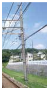
(更新前) コンクリート柱
