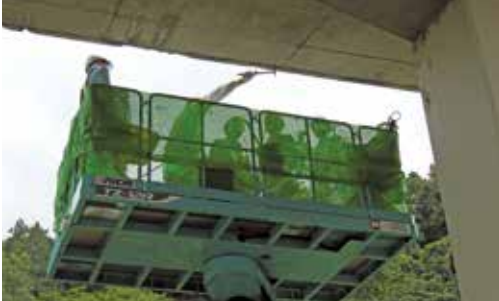
高架橋の点検作業の様子
