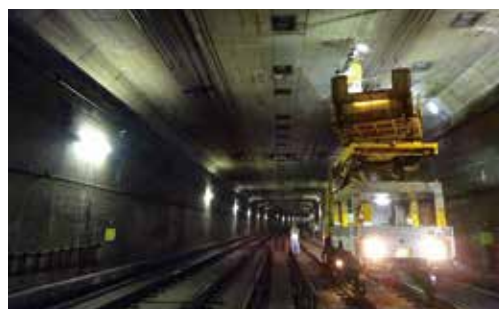
トンネル天井部の点検
