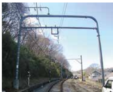
(更新後) 鋼管柱
