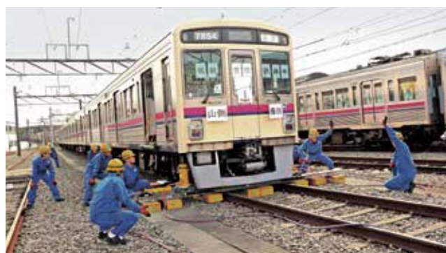
脱線車両の復旧
