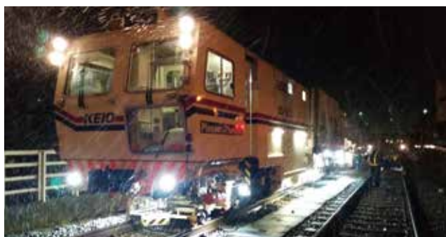
マルチプルタイタンパーによる道床のつき固め
