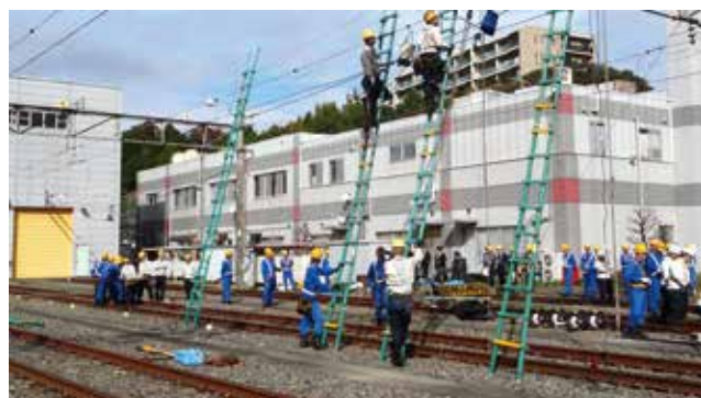
架線の張り替え
