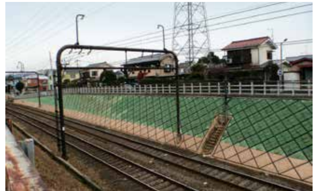
補強工事が完了した法面
