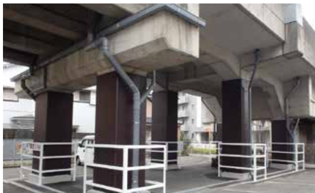
高架橋柱の耐震補強
