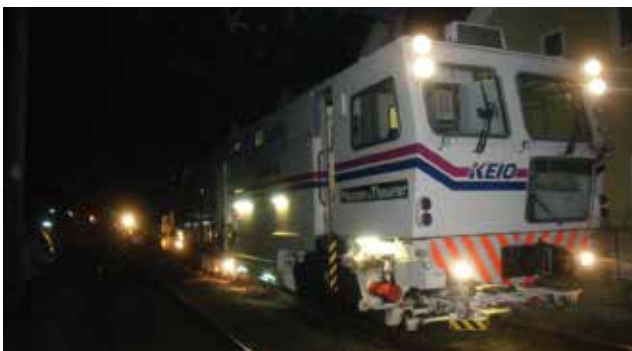
マルチプルタイタンパーによる道床つき固め
