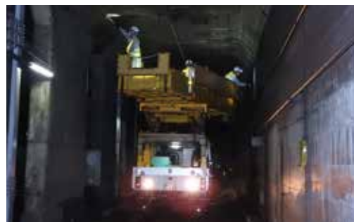
トンネル天井部の点検
