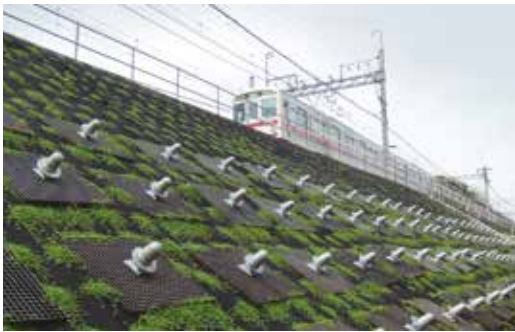
盛土区間の耐震補強
