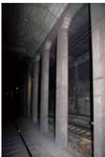
(補強前) 新宿トンネル中柱耐震補強
