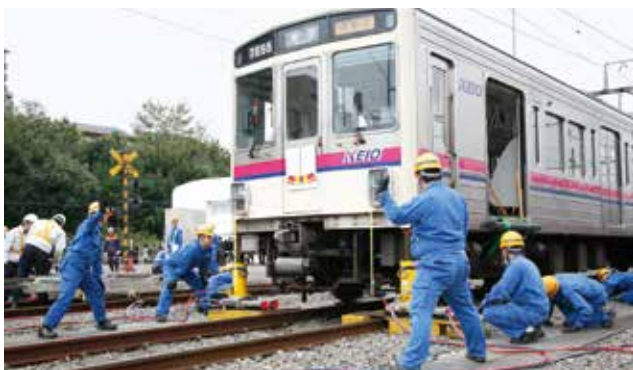
脱線車両の復旧
