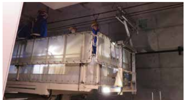
社長による夜間作業(架線補修)の視察
