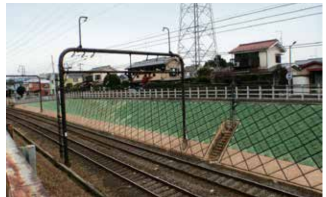
補強工事が完了した線路脇斜面
