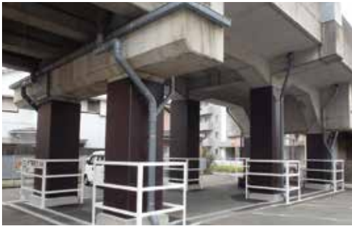
高架橋柱の耐震補強
