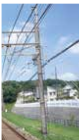
(更新前)コンクリート柱
