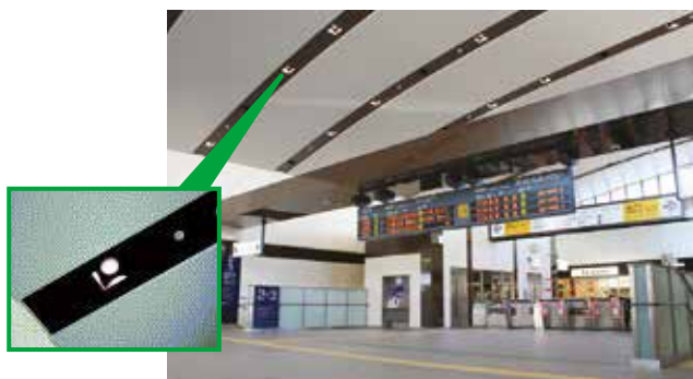
駅構内のLED照明
