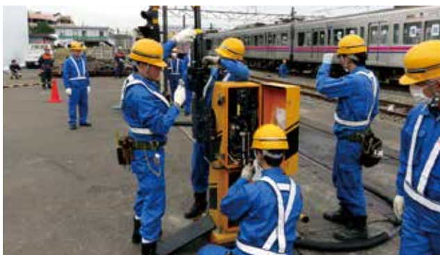
踏切保安設備の復旧
