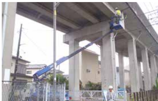
高架橋の点検作業
