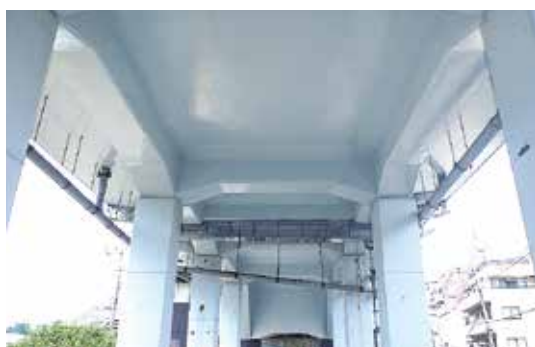
剥離対策を施した高架橋
