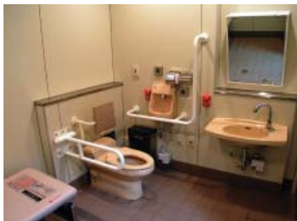
高尾山口駅の多機能トイレ
