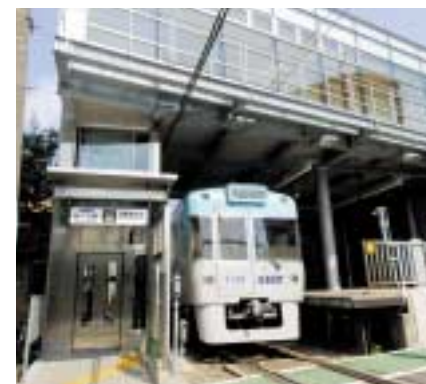
北側出入口を新設した池ノ上駅
